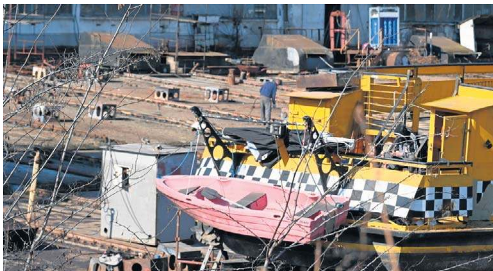
Wrocławska stocznia przeżywa wyjątkowo ciężkie chwile - pracownicy rozbierają pochylnię do naprawy statków. Deweloper chce tam postawić osiedle mieszkaniowe.
