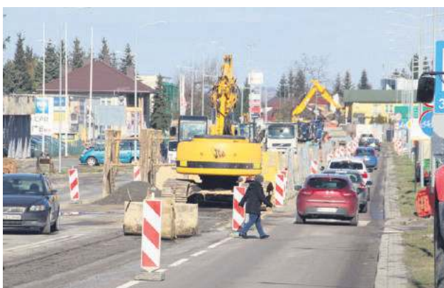
Remonty na ul. Lubelskiej w Zamościu trwają.
