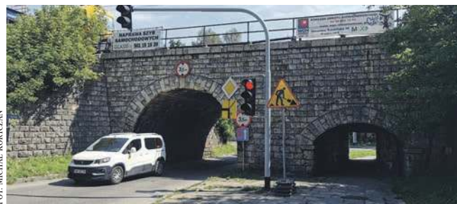
Wiadukt kolejowy nad ul. Sienną w Chrzanowie
