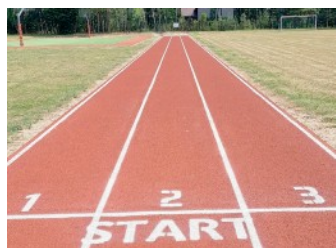
Gmina Joniec zakończyła budowę bieżni
