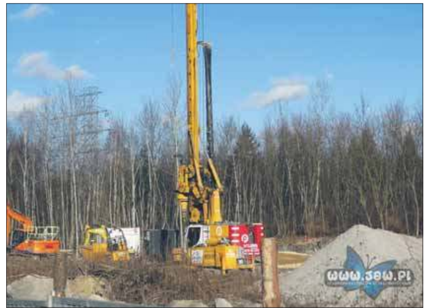
Budowa SUW „Jan Kanty”
