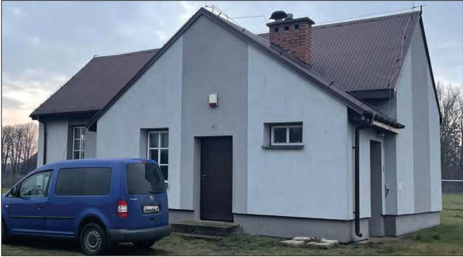
Stacja uzdatniania wody w Starym Zadybiu już niebawem przejdzie modernizację i unowocześnienie technologiczne
