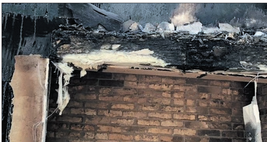
Fot. 1. Nieskuteczne nadproże z wełny mineralnej
