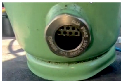
Rys. 3. Odstojnik oleju maszyny do płukania z olejem zanieczyszczonym po procesie płukania instalacji
