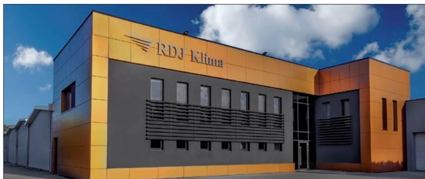
Fot. 1. Widok administracyjno-biurowej części budynku
