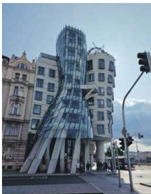
Tańczący Dom. Jego dekonstruktywistyczna forma budzi zainteresowanie na całym świecie.
