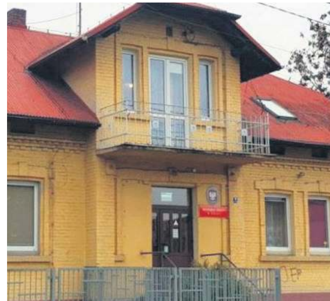
Komisariat w Libiążu. W ubiegłym roku ze względu na panujące w nim warunki (np. wilgoć, grzyb) miał być całkowicie zamknięty. Ostry przeciw mieszkańcom, samorządowców i lokalnych parlamentarzystów sprawił, że siedzibę na ile się dało „reanimowano” i zostawiono. Ile jeszcze wytrzyma?
