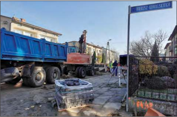
➤ Skrzyżowanie ulic Jana Pawła II i Wierusz-Kowalskiego w trakcie inwestycji i po zakończeniu
