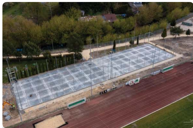
Modernizacja Hrubieszowskiego Ośrodka Sportu i Rekreacji.
