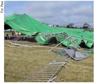
Zniszczone obiekty w Poświętnem
