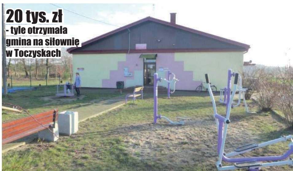
Urządzenia zostały już zamontowane. Pierwsi mieszkańcy skorzystali z aktywności na świeżym powietrzu
