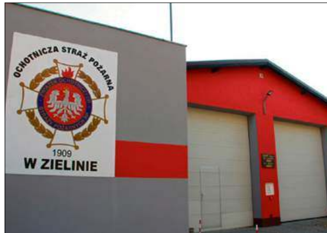
W Zielinie odmalowano elewację OSP.
