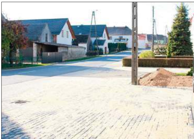
W Pisarzowicach wymieniono zniszczoną nawierzchnię betonową przy przystanku autobusowym.
