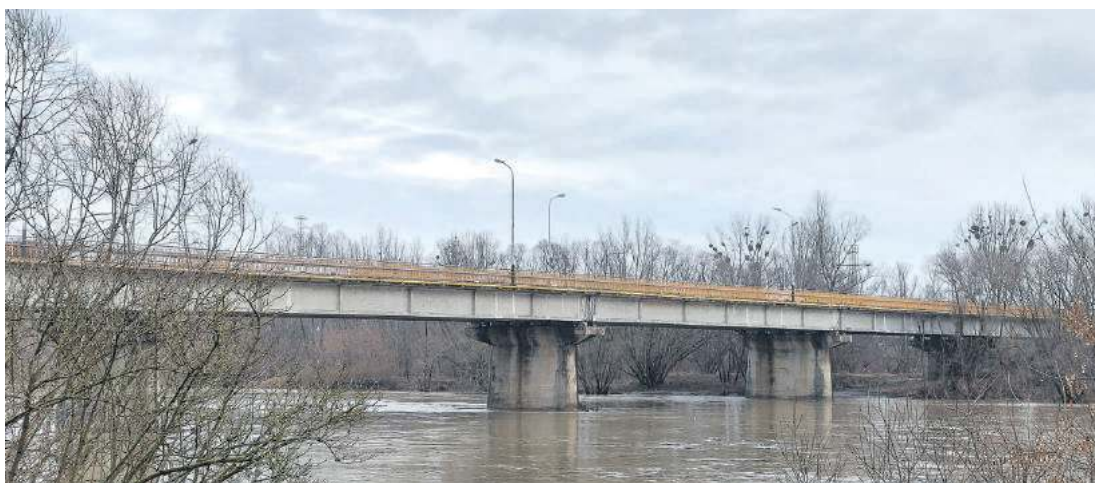
Końcem września ubiegłego roku zakończył się pierwszy etap przebudowy mostu, teraz przyszedł czas na etap drugi
