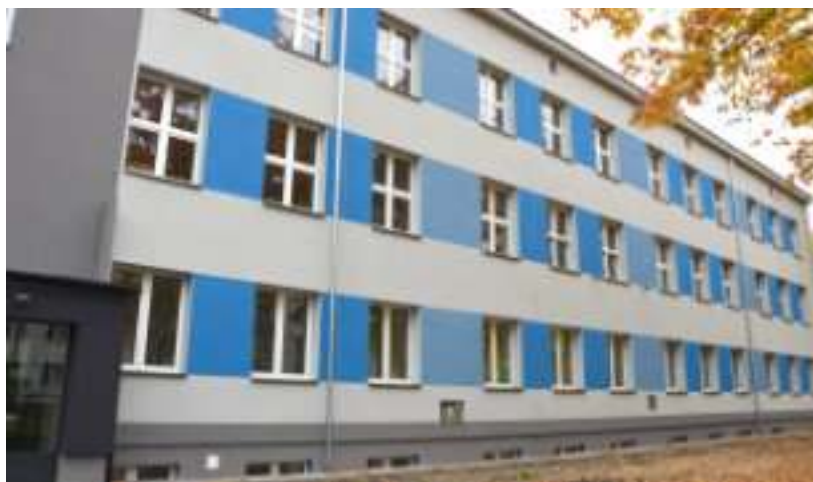
► Wyremontowany budynek szkoły Fot. UM Zabrze
