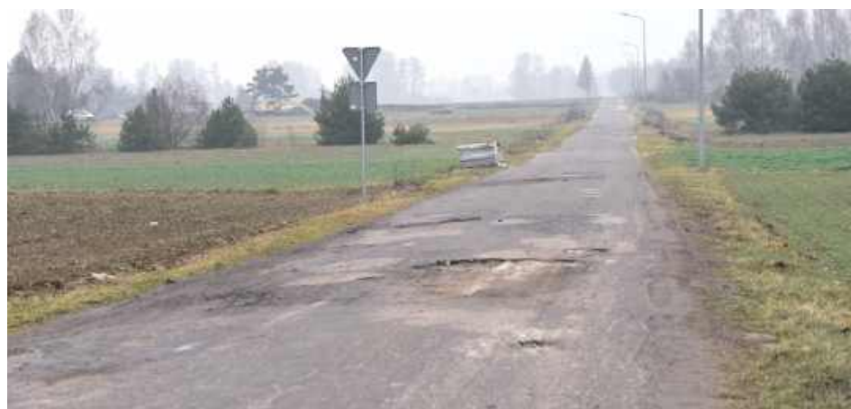
W bieżącym roku przebudowana zostanie droga gminna nr 101750L w Olszewnicy, na odcinku 666 metrów
