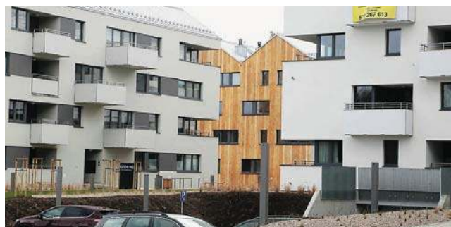
Nowe budynki i formy przy ul. Krasickiego w Olsztynie
