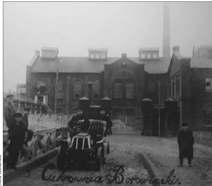
Stare zdjęcia wykonane w cukrowni ozdabia ściany siedziby archiwum
