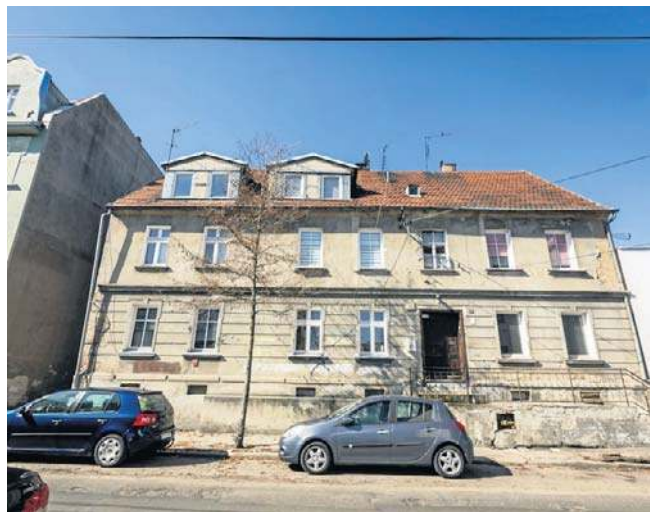
Przy ulicy Jasnej wypiękniało już kilkanaście budynków. Kolejne nieruchomości czekają na remonty
