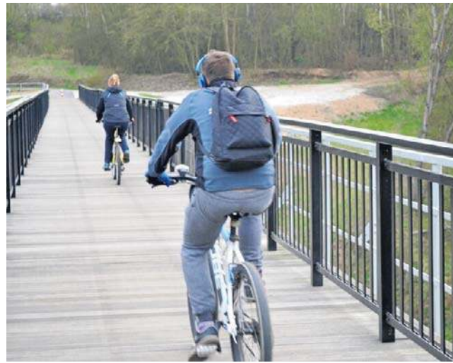
Burmistrz Patryk Mikołajewski cofnął decyzję o zamknięciu mostu kolejki wąskotorowej. Przeprawa będzie jednak czynna, pomimo trwających prac na osuwisku
