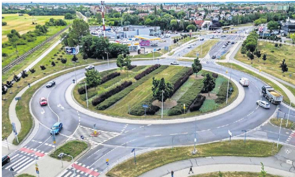
W tym miejscu powstanie wiadukt kolejowy w ciągu linii nr 751 i trasa tramwajowa na Muchobór Wielki. Termin? Do końca grudnia 2030 roku mają zniknąć rogatki
