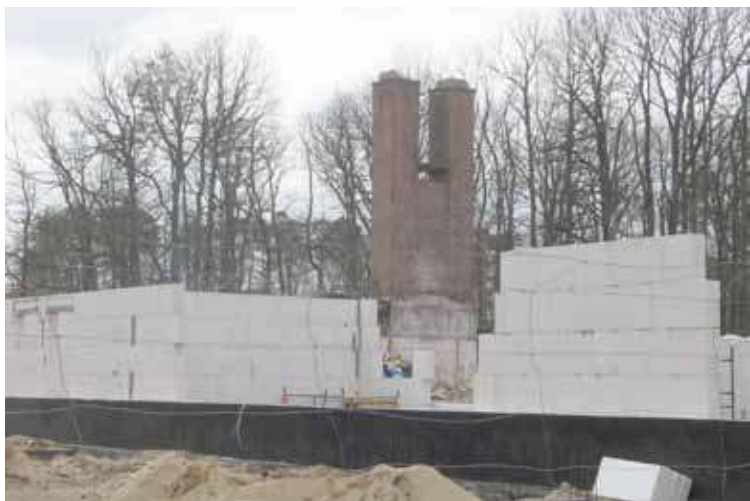
Krematorium tuż obok nowego domu
