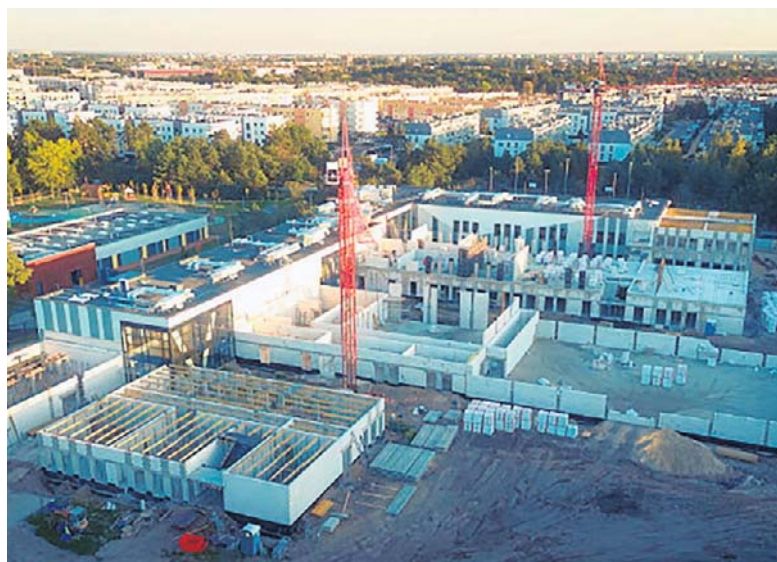
Stan surowy otwarty w powstającym obiekcie ma być osiągnięty do końca listopada tego roku
