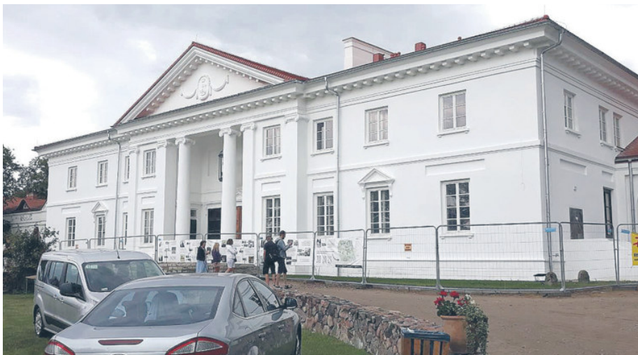
Pałac w Korczewie odzyskał formę sprzed pożaru.
