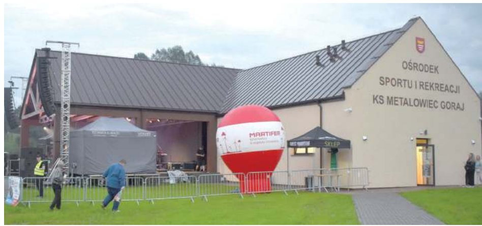
Nowy budynek OSiR w Zastawiu ma powierzchnię całkowitą 400 m2 i podzielony jest na kilka stref. Budynek jest już w pełni wyposażony w meble i niezbędne sprzęty
