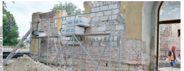
Jak widać na aktualnych zdjęciach, budowlancy mają jednak jeszcze „nieco” roboty
