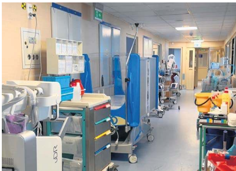
Wczoraj usuwano skutki pożaru i zadymienia w ICZMP
