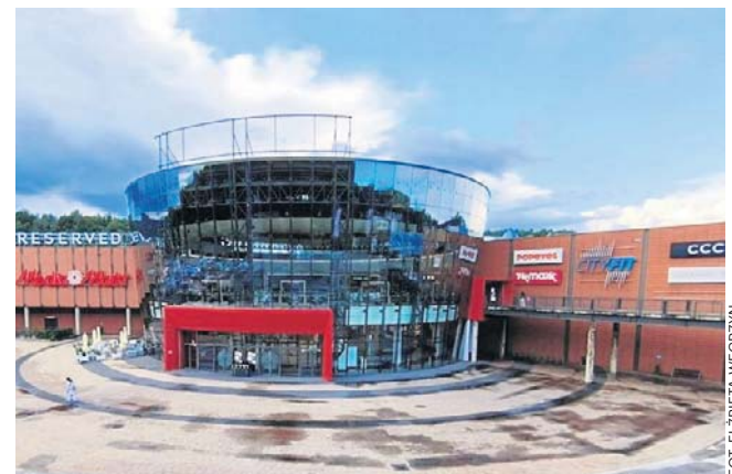
Z rotunda projektu Chapman Taylor International Services zniknął napis „Victoria”. Wróci po renowacji
