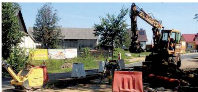
Na razie utrudnienia, ale już jesienią mieszkańcy Wituliny odczują znaczną poprawę
