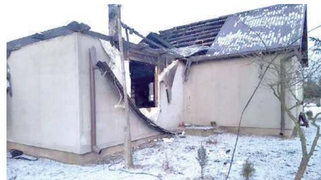
Dom po pożarze został rozebrany i w tym miejscu budowany jest nowy
