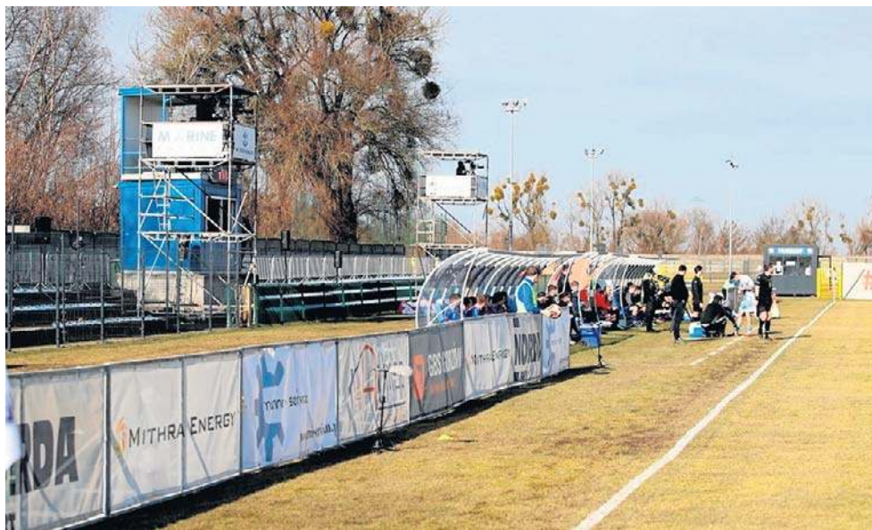
To w miejscu starej trybuny na powstać budynek z szatniami i nowa trybuna
