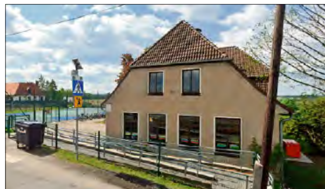
Termomodernizacja szkoły w Dańcu to kolejna inwestycja poprawiająca efektywność energetyczną w gminie Chrzastowice.
