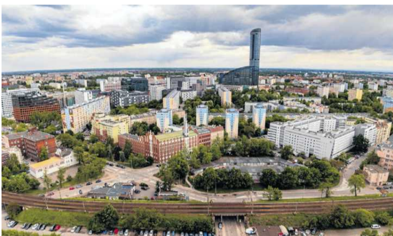
• Utrudnieniem inwestycji może być planowana zabudowa w rejonie Placu Rozjezdnego na miejscu dawnego szkieletora. FOT. KRZYSZTOF ZATYCKI / AGENCJA WYBORCZA.PL
