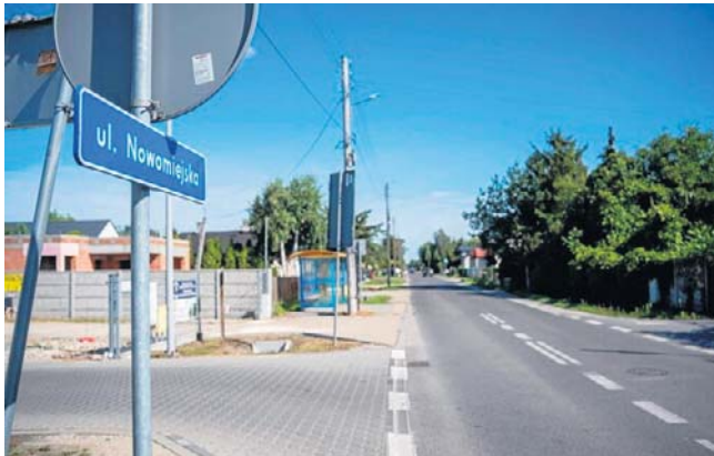
Utrudnienia związane z remontem Nowomiejskiej dotkną również pasażerów komunikacji miejskiej
