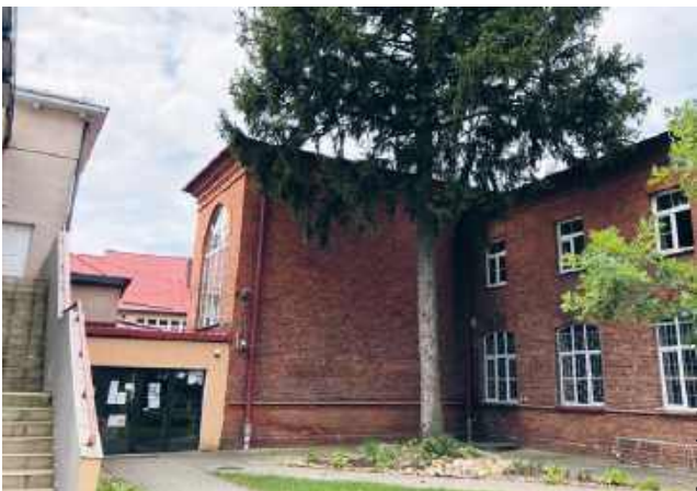
Obiekt przedszkola gminnego stanowi część budynku, w którym funkcjonuje Zespół Szkół
