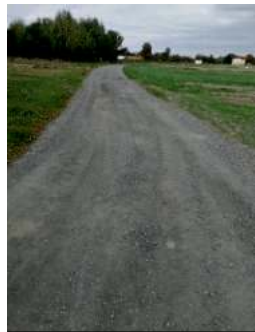
Wyremontowaliśmy drogi gruntowe
