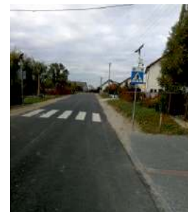
Zbudowaliśmy ponad 50 odcinków dróg asfaltowych
