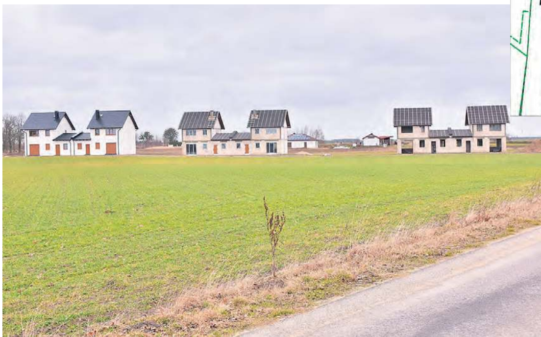
Przy ul. Kasztanowej powstaje osiedle tzw. bliźniaków.
