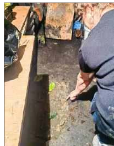
Lokatorka pokazuje podłogę w piwnicy.
