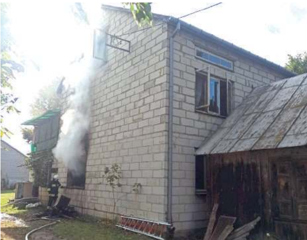
Dom gasiło ok. 30 strażaków
