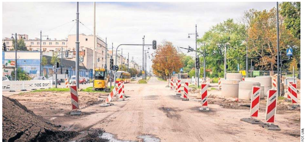
Prace zaczęły się w lipcu, wykonawca zapewnia, że wszystko idzie zgodnie z planem.
