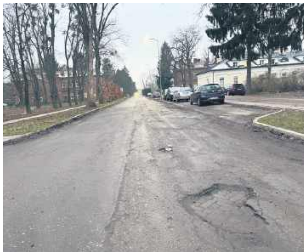
Po podpisaniu umowy wykonawca będzie miał maksymalnie 12 miesięcy na realizację inwestycji obejmującej trzy odcinki ulicy Koszary.
