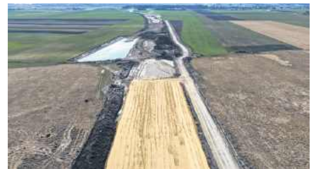
Budową drogi ekspresowej S17. Fot. GDDKiA
