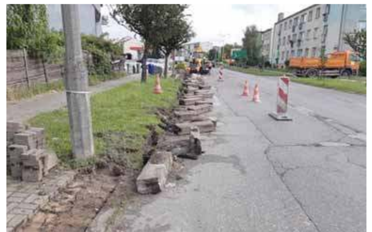
Wymiana krawężników na ul. Grzebskiego
