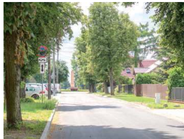
We wtorek, 25 czerwca odbył się odbiór końcowy inwestycji drogowych na ul. Wilczyńskiego oraz Kryńskiego (fot. Miasto Łuków)
