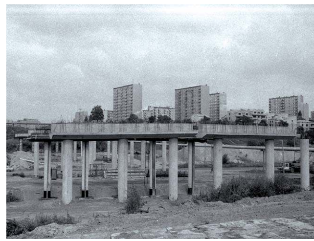
Budowa wiaduktu nad ulicą Filaretów
