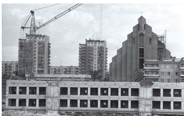
Budowa Kościoła Świętej Rodziny przy ulicy Jana Pawła II FOT. TEATR NN, KOLEKCJA JACKA MIROSLAWA
