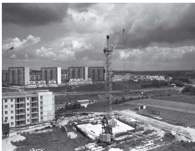
Budowa osiedla Skarpa
