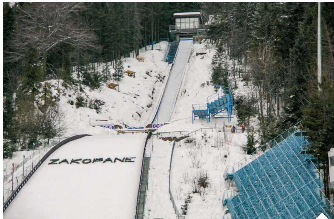
Burmistrz Zakopanego apeluje do kibiców skoków narciarskich, aby z uwagi na trudne warunki i zamknięcie niektórych ulic poruszać się po Zakopanem pieszo lub komunikacją zbiorową | fot. Wikipedia/d
