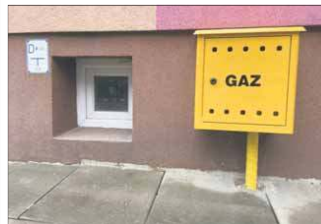
Spółdzielnia prowadzi obecnie prace związane z przeniesieniem zaworów
