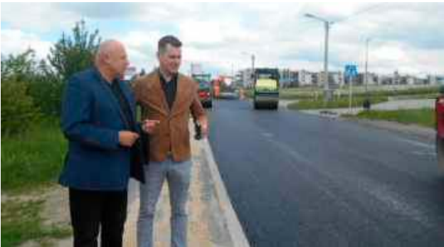
W miniony czwartek, po przerwie wywołanej złymi warunkami atmosferycznymi, układano ostatnią, ścieralną warstwę jezdni. Od lewej wiceprzewodniczący Leszek Daniewski i dyr. Jarosław Jakimiec
