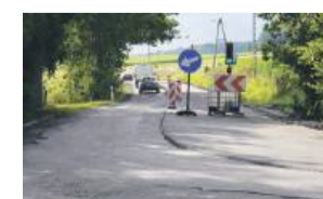
Trwają prace remontowe w Jagielnicy
