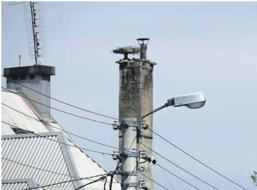
Właściciel zamontował na piekarni platformę, tak by bociany mogły bezpiecznie budować nowe gniazdo.
