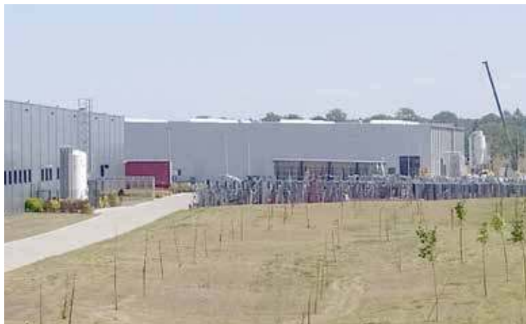
Zakład widziany z zewnątrz od strony wiaduktu przy ul. gen. J. Bema jest już blisko końca budowy
