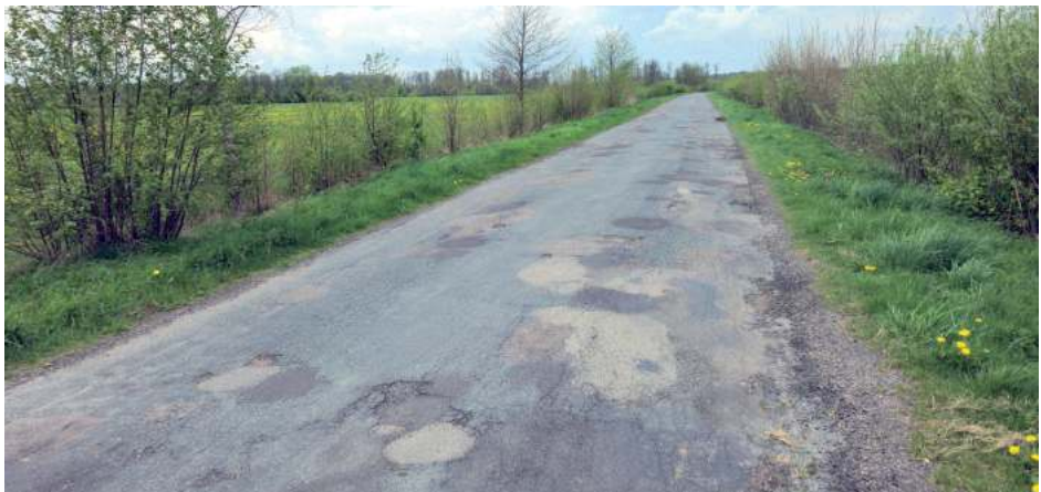
Wyremontowanych zostanie także 980 metrów drogi powiatowej w Sokulu. Poza dofinansowaniem wkład własny tej inwestycji zostanie podzielony po połowie między gminą Kąkolewnica a powiatem radzyńskim
