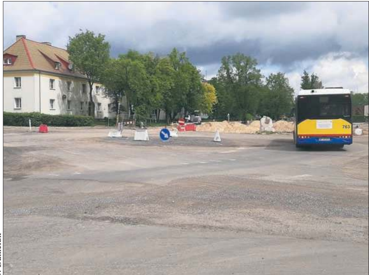
Trwa budowa ronda na skrzyżowaniu al. Kilińskiego z ul. Mostową, Warszawską i Norbertańską
