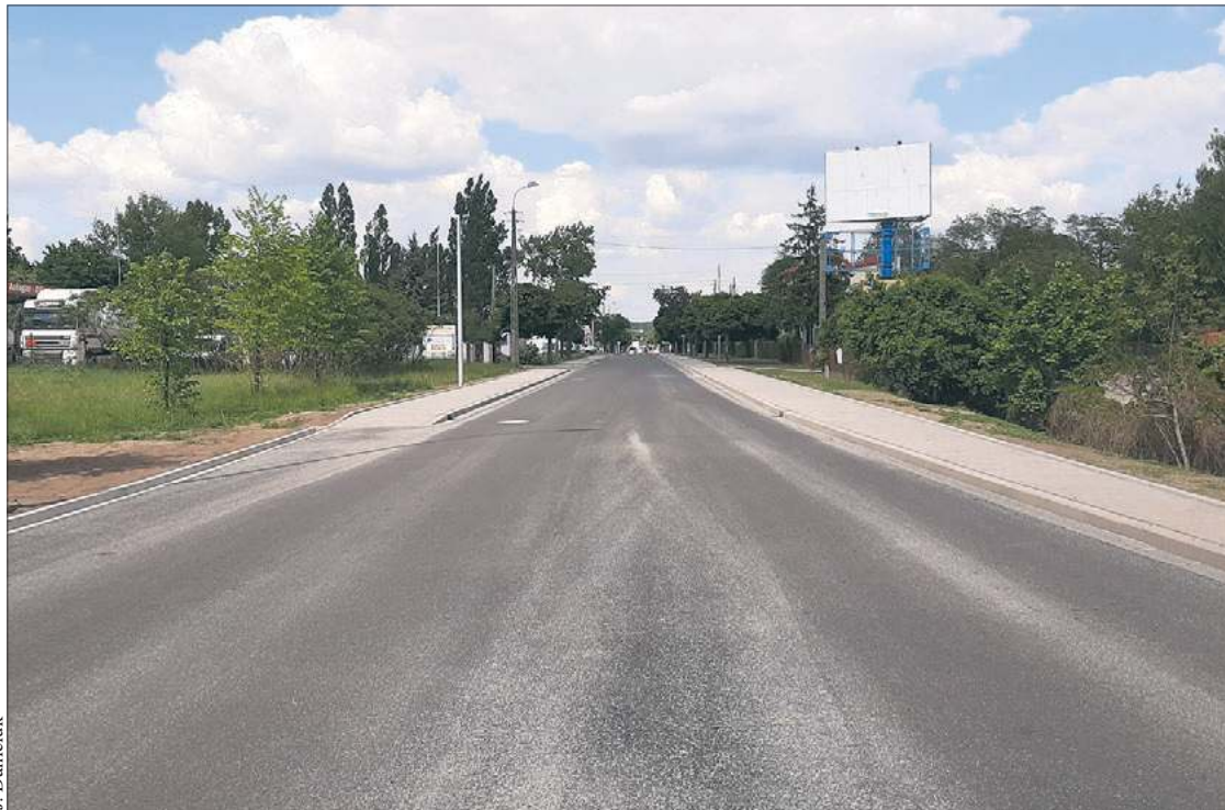
W ubiegłym tygodniu prace budowlane na ulicy Kolejowej były już zakończone. Do wykonania zostało jedynie oznakowanie pionowe, bez którego – ponieważ jest to droga krajowa – ruch nie może być przywrócony
