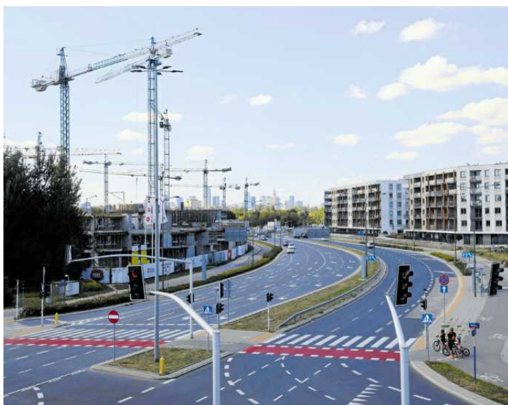
• Budowa osiedla w rejonie al. Polski Walczącej, sierpień 2024 r.
